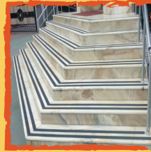
Kayırmaz Bant Uygulaması
