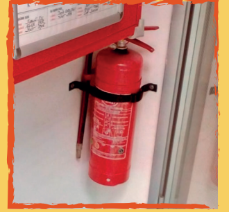
QH5601 – Yangın Tüpü Sabitleme Elemanı / Deprem vb. Sebeplerle Devrilmemesi İçin
